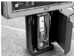
Le socle s'ouvre par moitié: deux trous ronds, en-haut des flancs, contiennent chacun une vis que l'on dévisse avec une clé Allen (= tige hexagonale) de 4 mm, mais avec un bon manche: les vis sont serrées très fort.
