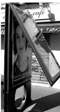
La méthode (ci-dessus): glisser le tournevis dans la vis, entre la tige et les pans hexagonaux. Une légère rotation permet de déverrouiller la plaque vitrée, qu'il suffit alors de tirer pour ouvrir le panneau: photo du résultat à droite.
