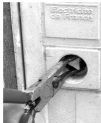
← 2) ouvrir le boîtier. Certains ont une fente allongée et s'ouvrent avec un gros tournevis plat ou une clef de serrure standard, mais la majorité ont une serrure triangulaire qui s'ouvre facilement avec une simple clé d'électricien à bout coudé:
